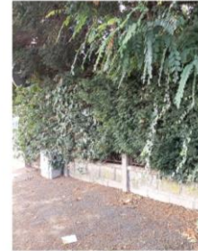
Clôture avec soubassement qui retient le sol sur l'arrière
